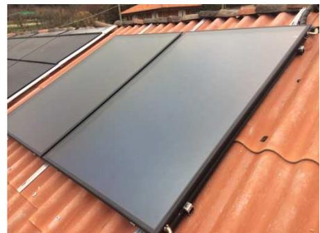
Sul tetto dell'abitazione trova spazio l'impianto fotovoltaico con potenza nominale di 5,10 kWp, anch'esso progettato ed installato dalla società SINERGICHA, è composto da moduli innovativi perfettamente integrati sulla copertura dell'abitazione.
