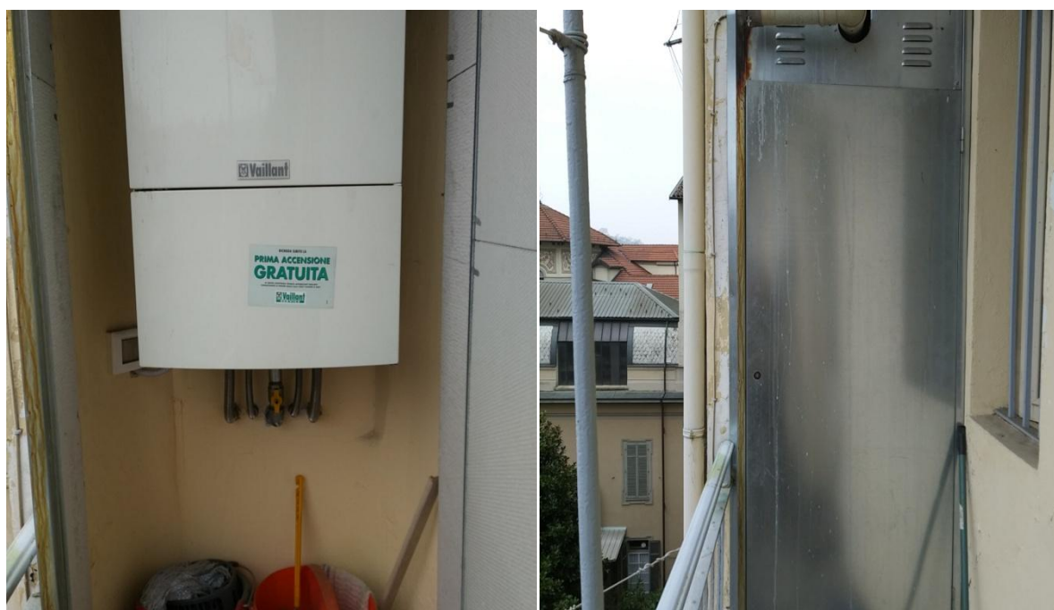
Figura 1 Situazione antecedente all'intervento
