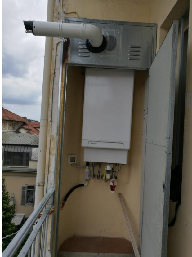
Figura 2 Nuove caldaia DAIKIN
