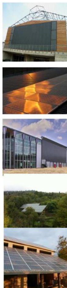
Figura 2 dati relativi all'impianto fotovoltaico
