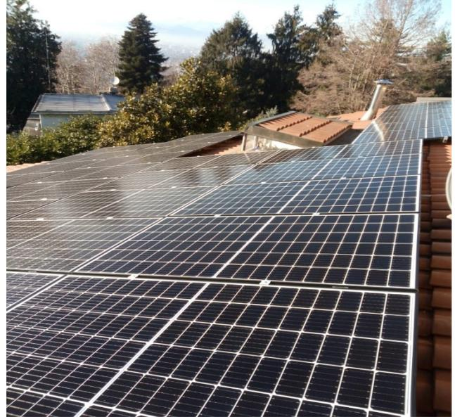
Sul tetto dell'abitazione trova spazio l'impianto fotovoltaico con potenza nominale di 5,53 kWp. Anch'esso progettato ed installato dalla società SINERGICHA, è composto da moduli tradizionali da 325 W ciascuno. L'impianto è, inoltre, dotato di un sistema di accumulo, mediante batterie SONNEN di capacità 5 kWh.
