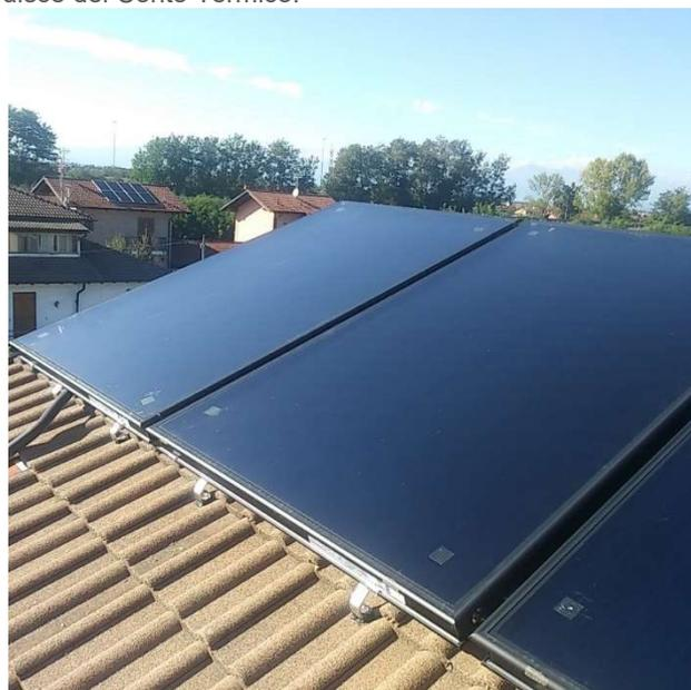
L'impianto solare termico DAIKIN è in grado di trasformare fino all'80% dell'energia in calore utile ed è integrabile perfettamente a qualsiasi sistema di riscaldamento. I collettori piani DAIKIN Solaris hanno elevati rendimenti e l'abbinamento con l'accumulo rapido e diretto del calore ottenuto nell'accumulatore solare garantisce un elevato sfruttamento energetico anche con un irraggiamento relativamente basso.
