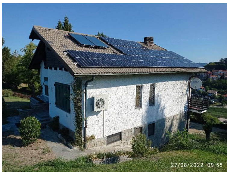
Foto 3. Impianto fotovoltaico e collettori solari termici
