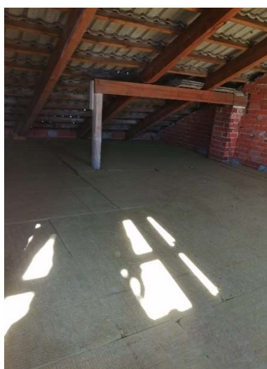
Foto 10-11-12 Posa di isolante in lana di roccia e pannelli OSB su solaio sottotetto
