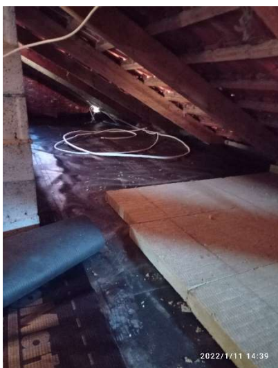
Foto 10-11-12 Posa di isolante in lana di roccia e pannelli OSB su solaio sottotetto
