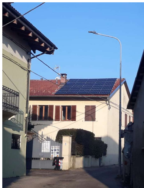
Foto 3. Impianto fotovoltaico terminato
