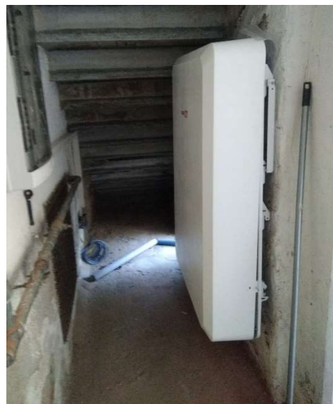
Foto 6. Batteria Solaredge
