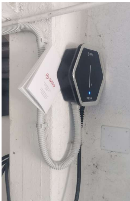
Foto 7. Colonnina di ricarica Prism Solar RFID
