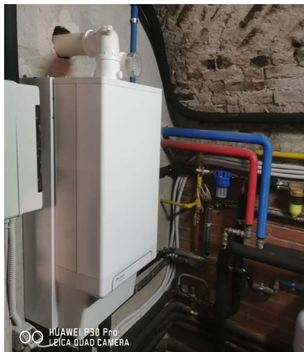
Foto 2. Caldaia a condensazione
