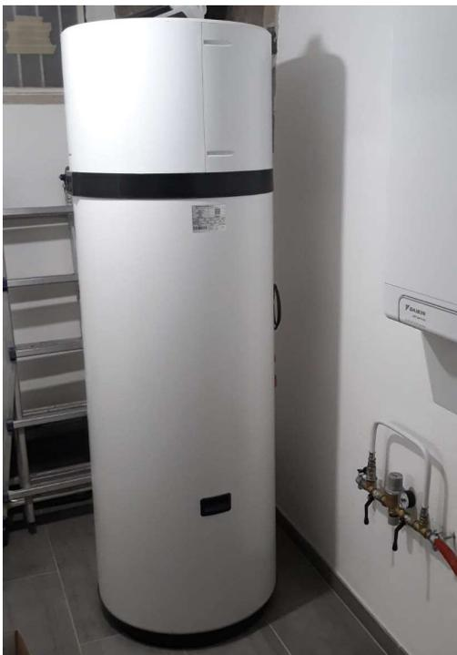
Foto 1. Pompa di calore produzione ACS
