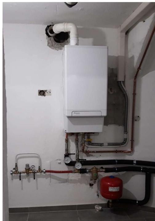
Foto 2. Caldaia a condensazione
