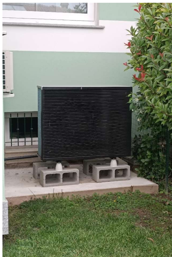
Foto 1 Macchine interna ed esterna pompa di calore elettrica EPRA18
