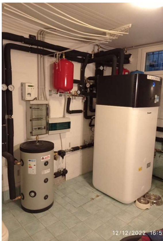
Foto 1 Macchine interna ed esterna pompa di calore elettrica EPRA18
