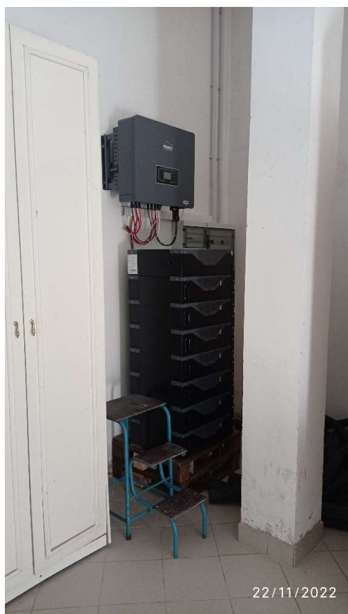
Foto 3-4. Pacco batterie WECO e inverter ZCS e posizione moduli su falde
