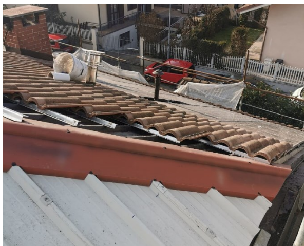
Foto 4. Sostituzione orditura in legno
