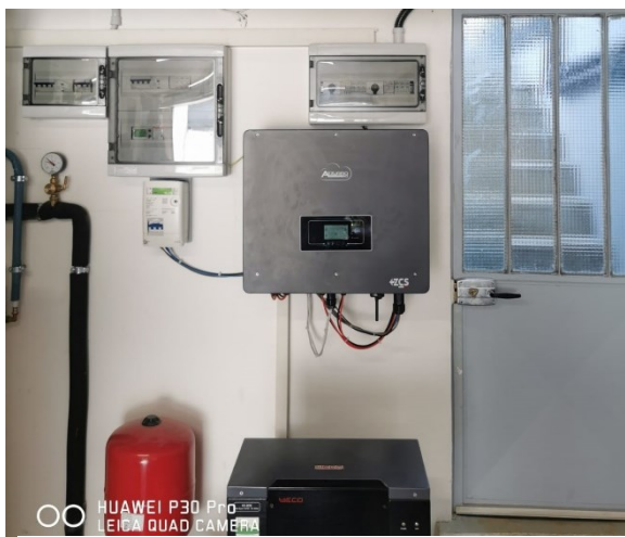
Foto 6. Inverter ZCS e batterie WECO
