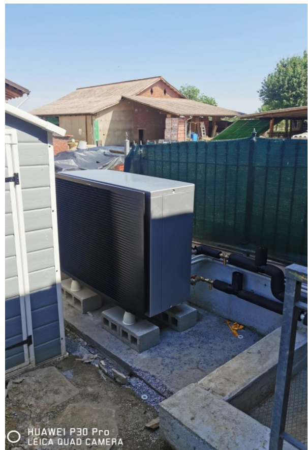
Foto 1-2 Macchine interna ed esterna pompa di calore elettrica EPRA18
