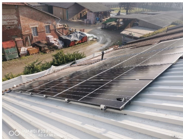
Foto 5. Posa pannelli fotovoltaici su lamiera grecata
