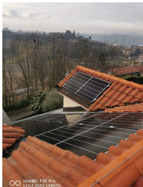
Foto 2-3-4. Impianto fotovoltaico terminato, rifacimento copertura, posizionamento lamiera
