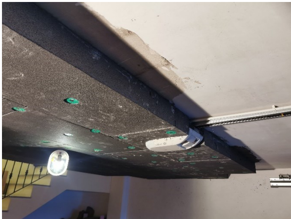
Foto 6-7-8-9.Posa isolante e intonachino pareti esterne e solai
