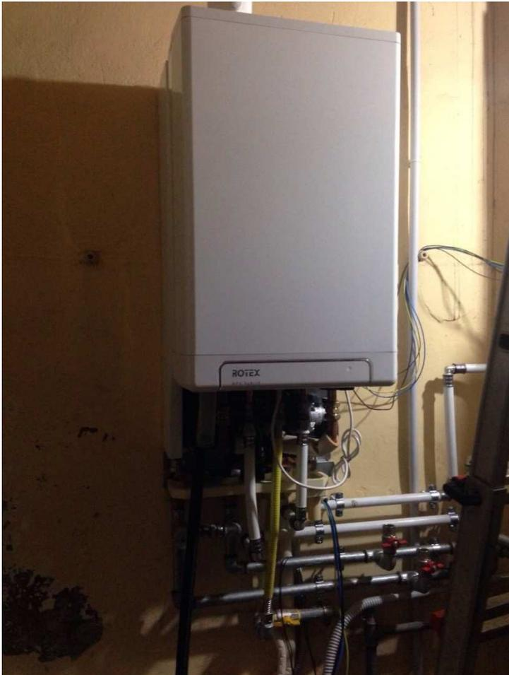
Nello specifico, la pompa di calore elettrica **HPU Hybrid** permette di essere allacciata direttamente all'impianto di riscaldamento esistente, senza intervenire sui radiatori (eccetto che per l'eventuale installazione delle valvole termostatiche) e sul sistema di distribuzione presente.
