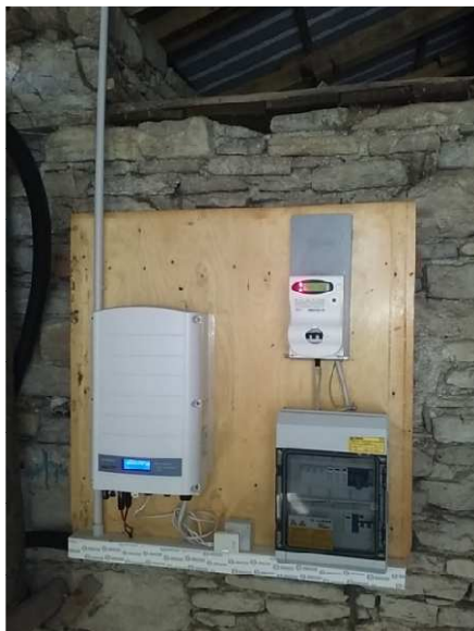
Inverter, contatore e quadro CC/AC e relative protezioni
