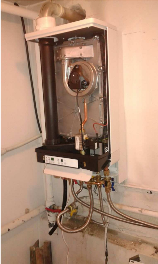
Caldaia a condensazione ROTEX Full Condens, vista interna.
