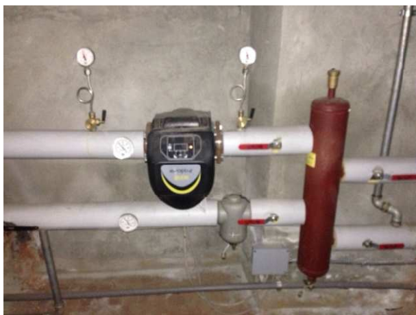
Pompa a giri variabile Compensatore idraulico Defangatore magnetico coibentato
