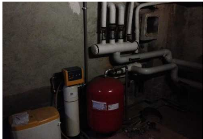
Gruppo di addolcimento e di mandata per i radiatori del condominio
