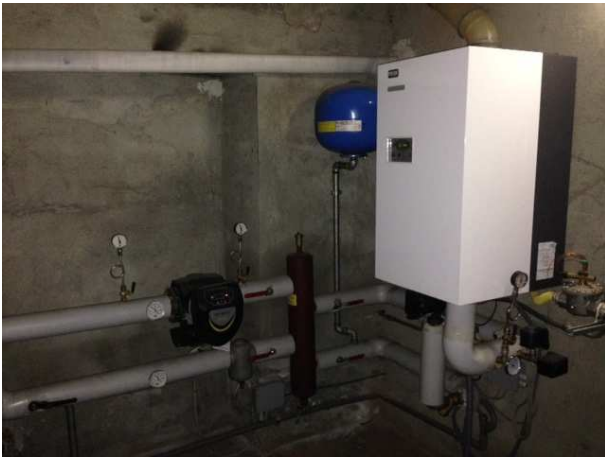
Nuova caldaia a condensazione RIELLO ALU PRO
