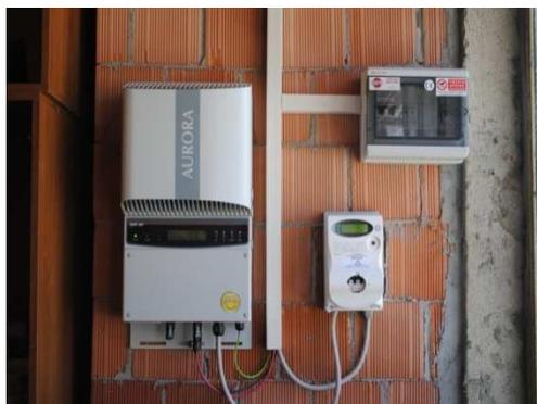
L'inverter installato prodotto da POWER ONE collegato al contatore bidirezionale di produzione e al quadro di camp AC DC.
