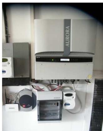
L'inverter installato prodotto da POWER ONE collegato al contatore bidirezionale di produzione e al quadro di camp AC DC.
