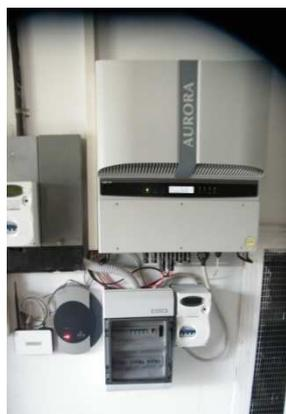
L'inverter installato prodotto da POWER ONE collegato al contatore bidirezionale di produzione e al quadro di campo AC DC.
