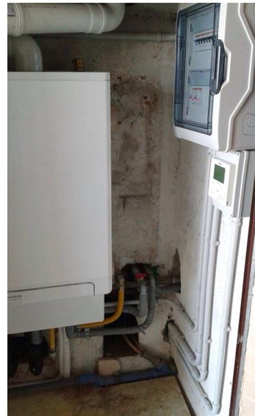
L'impianto è predisposto per il raffrescamento degli ambienti e il successivo step sarà l'installazione di un sistema idronico che grazie alla pompa di calore produca acqua refrigerata che consenta il raffrescamento del primo piano dell'abitazione.
