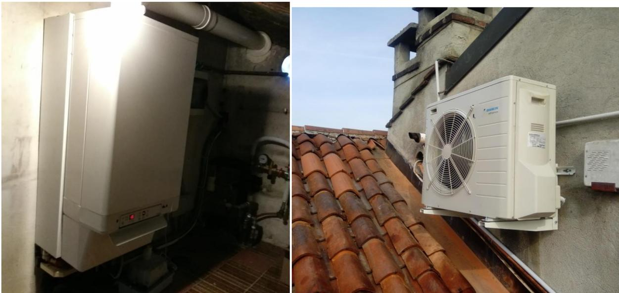
Durante il periodo estivo la macchina raffredda l'acqua da mandare ai ventilconvettori, in questo modo è possibile raffrescare gli ambienti ottenendo un confort ottimale anche in estate.
