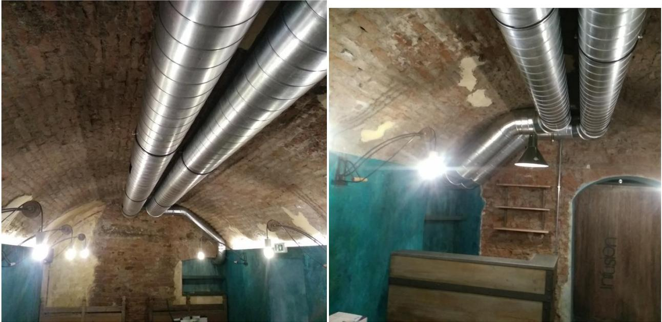
**Figura 2 Tubazioni per la ventilazione meccanica**
