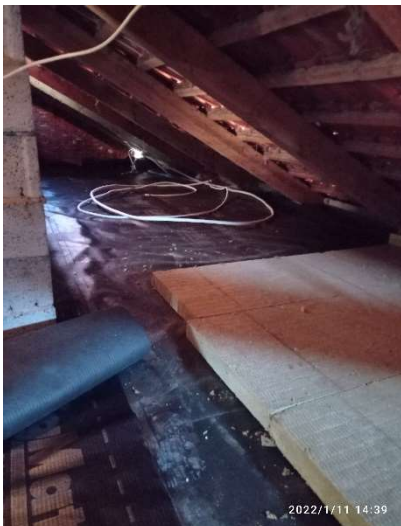
Foto 10-11-12 Posa di isolante in lana di roccia e pannelli OSB su solaio sottotetto
