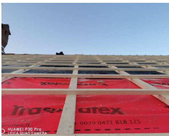
Foto 4. Sostituzione orditura in legno
