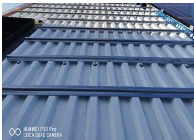
Foto 5. Posa pannelli fotovoltaici su lamiera grecata
