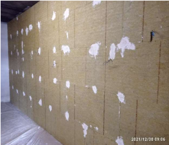
Foto 7-8-9 Posa di isolante in lana di roccia su pareti
