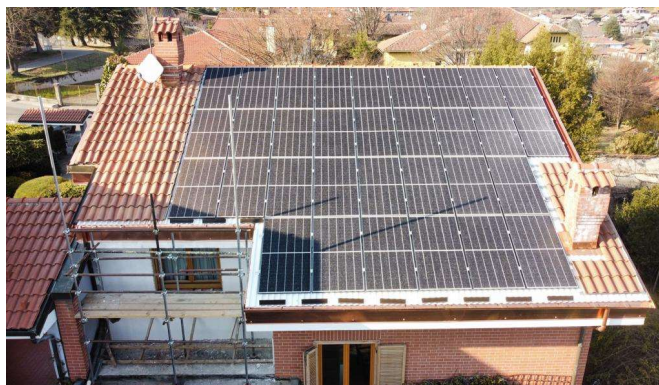
Foto 3. Impianto fotovoltaico terminato e nuovi faldali in rame
