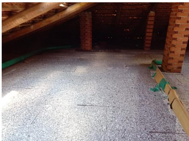
Foto 7. Isolante in ESP sottotetto
