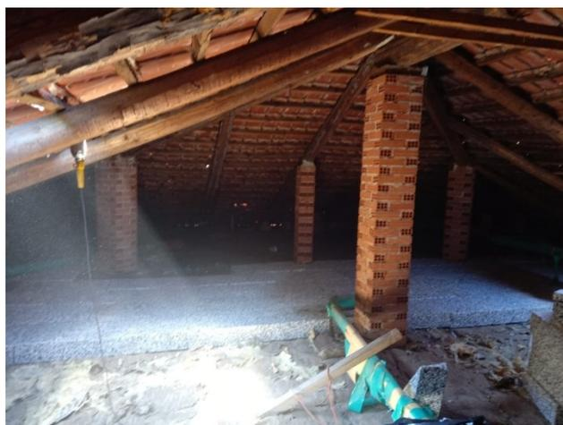
Foto 6. Posa isolante in ESP sottotetto
