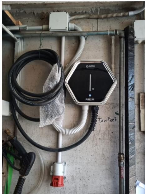
Per completare gli interventi di efficientamento energetico è stata installata una colonnina di ricarica PRISM SOLAR RFID in grado di usare l'energia prodotta dall'impianto fotovoltaico per la ricarica dell'auto, inoltre regola automaticamente i consumi per evitare il distacco dalla rete. E' resistente alla pioggia, può esser gestita tramite smartphone e si connette ad internet tramite Wi-Fi o via ethernet.
