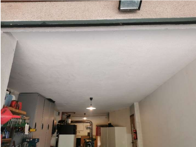
Foto 4. Intradosso solaio interpiano isolato e intonacato
