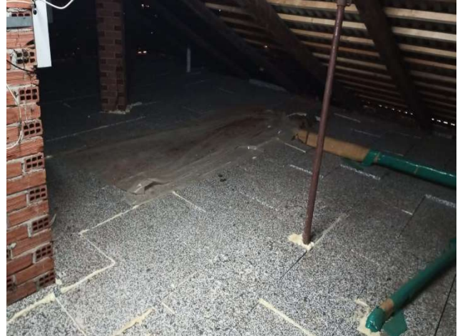
Foto 5. Posa isolante in ESP sottotetto
