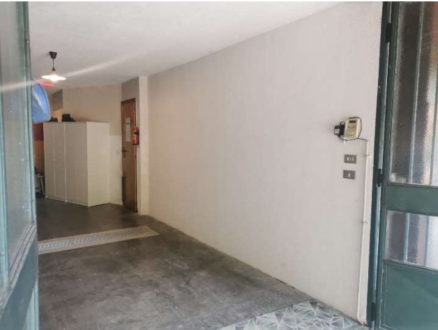
Foto 6. Parete verso locale non riscaldato isolata e intonacata
