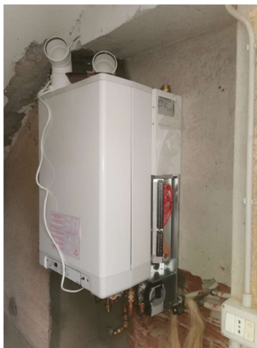
Foto 2. Caldaia a condensazione
