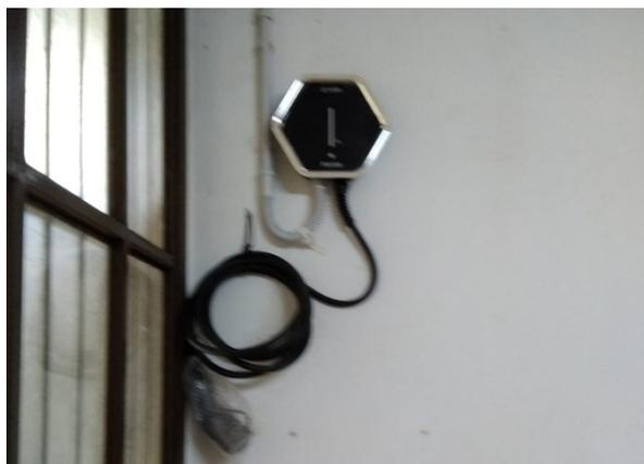
Per completare gli interventi di efficientamento energetico è stata installata una colonnina di ricarica PRISM SOLAR RFID in grado di usare l'energia prodotta dall'impianto fotovoltaico per la ricarica dell'auto, inoltre regola automaticamente i consumi per evitare il distacco dalla rete. E' resistente alla pioggia, può esser gestita tramite smartphone e si connette ad internet tramite Wi-Fi o via ethernet.
