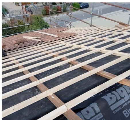
*Foto 7-12. Fasi di isolamento delle pareti verticali e della copertura civile inclinata*
