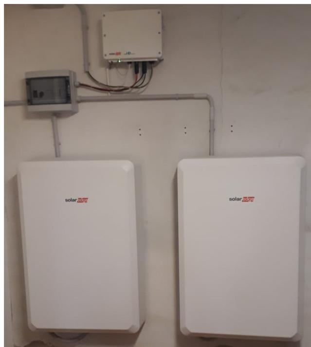
Foto 6. Inverter e accumulo SOLAREEDGE
