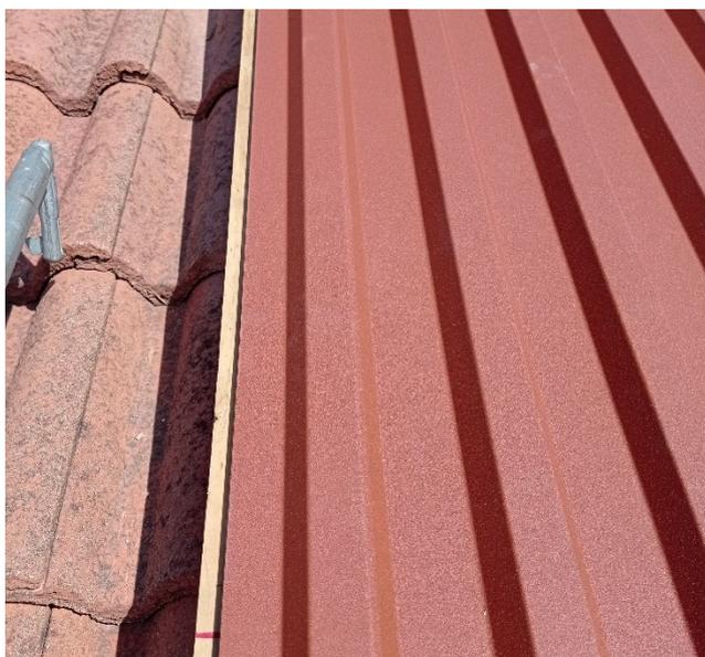
Foto 5. Posa lamiera grecata previa installazione impianto fotovoltaico
