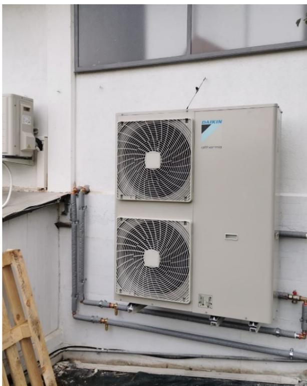
Foto 1. Macchina esterna pompa di calore bassa temperatura
