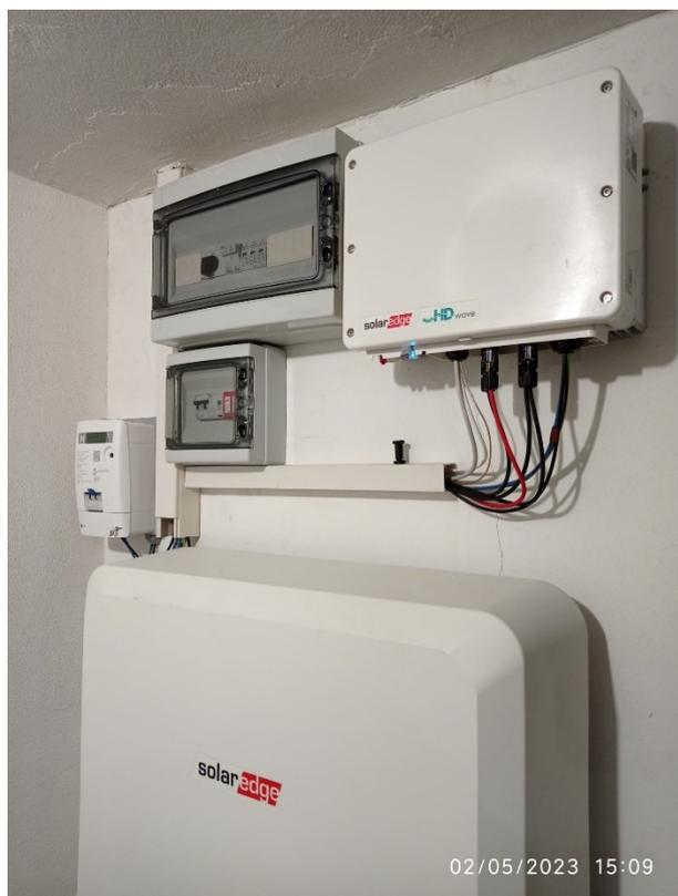
Foto 5. Quadro elettrico, inverter e sistema di accumulo Solaredge
