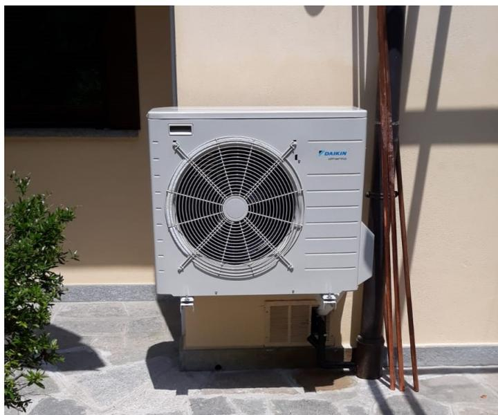
Foto 1. Macchina esterna pompa di calore Hybrid
