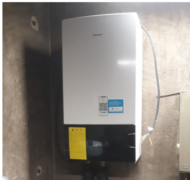
Foto 3-4. Impianto termico Daikin Altherma 3H HT
