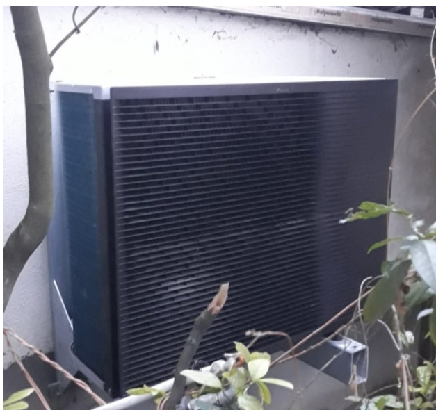
Foto 3-4. Impianto termico Daikin Altherma 3H HT
