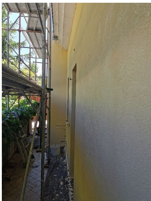
Foto 6-7-8-9. Posa isolante e intonachino
