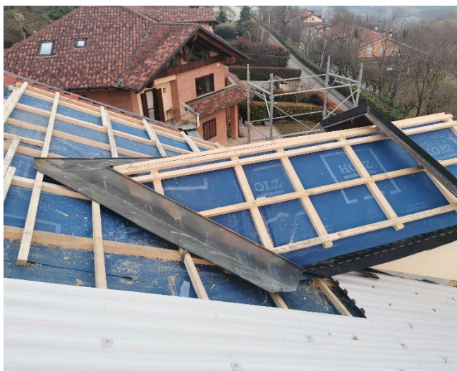
Foto 2-3-4. Impianto fotovoltaico terminato, rifacimento copertura, posizionamento lamiera
