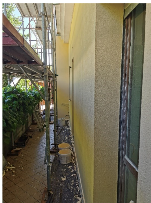
Foto 6-7-8-9. Posa isolante e intonachino
