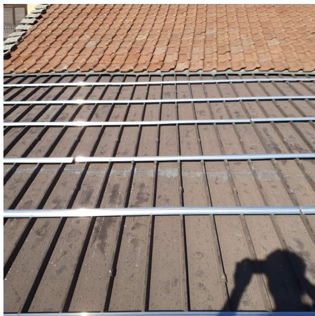
Foto 1-2.-3. Impianto fotovoltaico terminato, posa dei profili in alluminio su lamiera e dettaglio profilo
