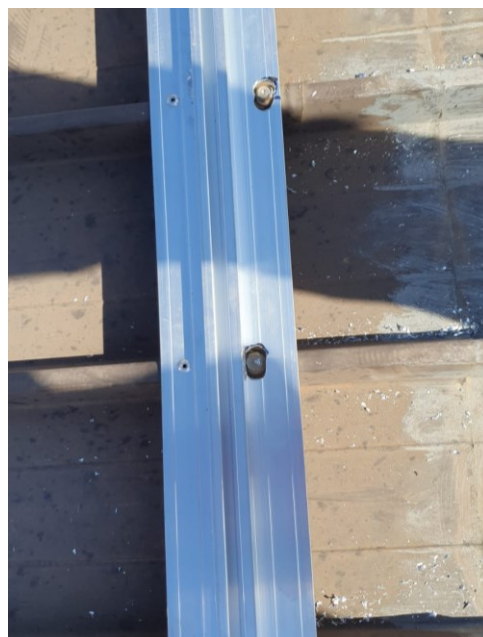
Foto 1-2.-3. Impianto fotovoltaico terminato, posa dei profili in alluminio su lamiera e dettaglio profilo
