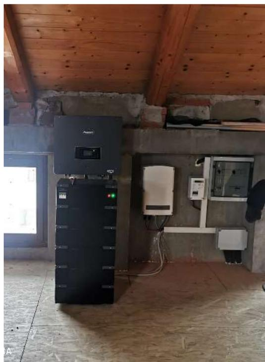
*Foto 4. Inverter SOLAREEDGE e sistema batterie WECO*
