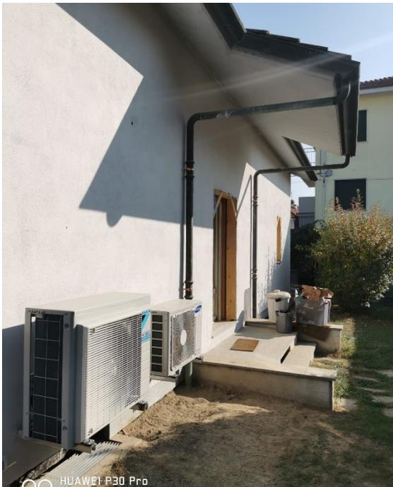
Foto 1. Macchina esterna pompa di calore Hybrid
