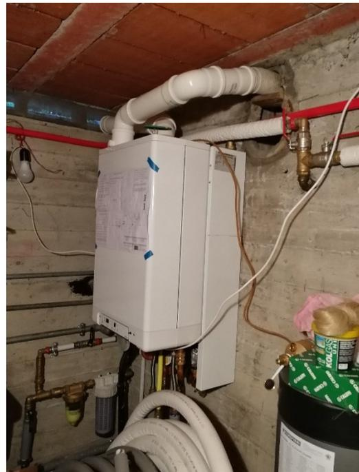
Foto 2. Caldaia a condensazione
