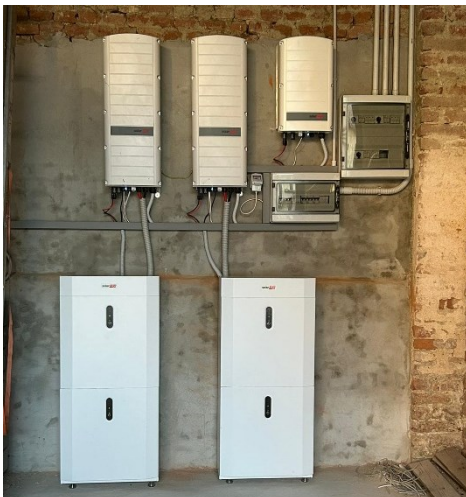
Foto 2-3 Inverter e sistema di accumulo – installazione moduli su profili in alluminio
