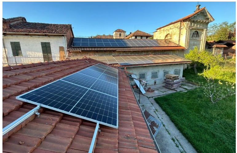
Foto 2-3 Inverter e sistema di accumulo – installazione moduli su profili in alluminio
