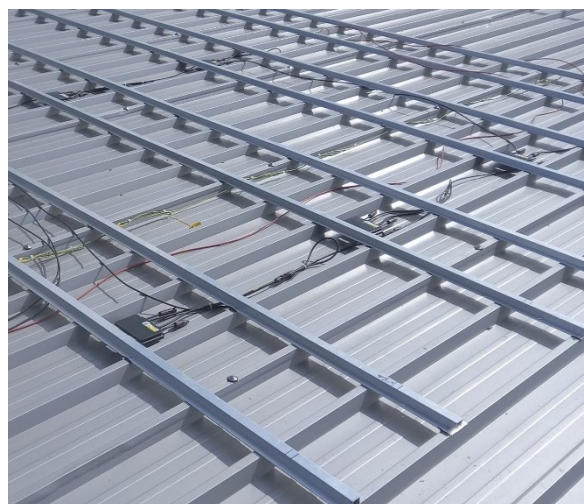
Foto 2-3. Sistema di accumulo - installazione profili in alluminio e ottimizzatori di potenza Tigo
