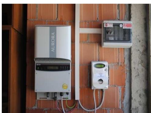
L'inverter installato prodotto da POWER ONE collegato al contatore bidirezionale di produzione e al quadro di campo AC DC.
