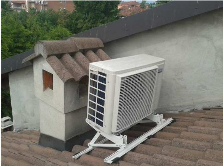
Nel nuovo impianto, il climatizzatore Daikin Emura garantisce la produzione di calore per il periodo invernale e il raffrescamento nel periodo estivo. Il condizionamento termico dell'edificio è garantito dal funzionamento caldo freddo reversibile a seconda della stagione di esercizio.
