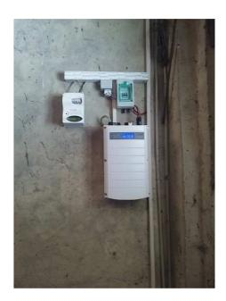
L'inverter installato prodotto da SOLAREDGE permette il controllo diretto dell'energia prodotta da ogni pannello. In questo modo, è possibile controllare le prestazioni dell'impianto, dei singoli pannelli e l'efficacia degli ottimizzatori di potenza.
